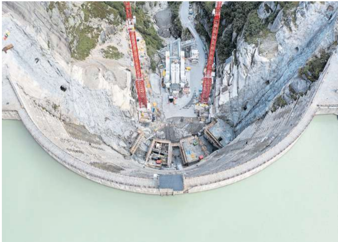
Die Staumauer Spitalamm an der Grimsel im September 2021. Um die Stromproduktion langfristig zu garantieren, wird sie bis 2025 ersetzt. Die alte Mauer bleibt erhalten und wird geflutet. GAËTAN BALLY / KEYSTONE
