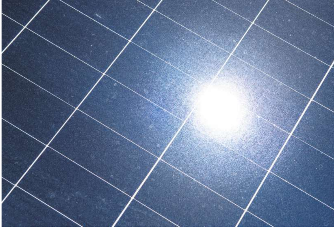
Mehr als 1200 Photovoltaikmodule werden an der Oberlandautobahn installiert.
